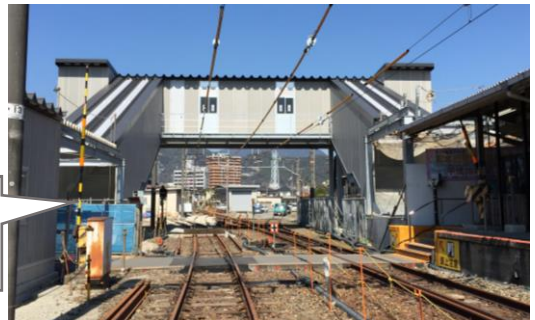
写真② 可部駅構内の工事状況
